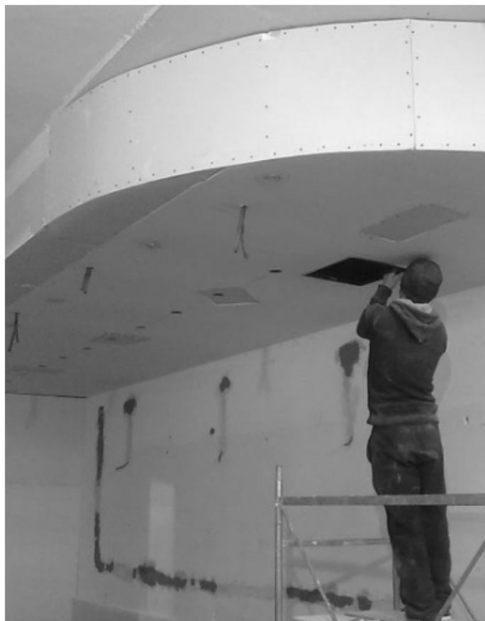
LAVORI IN CORSO La sede di Foggia della gelateria
